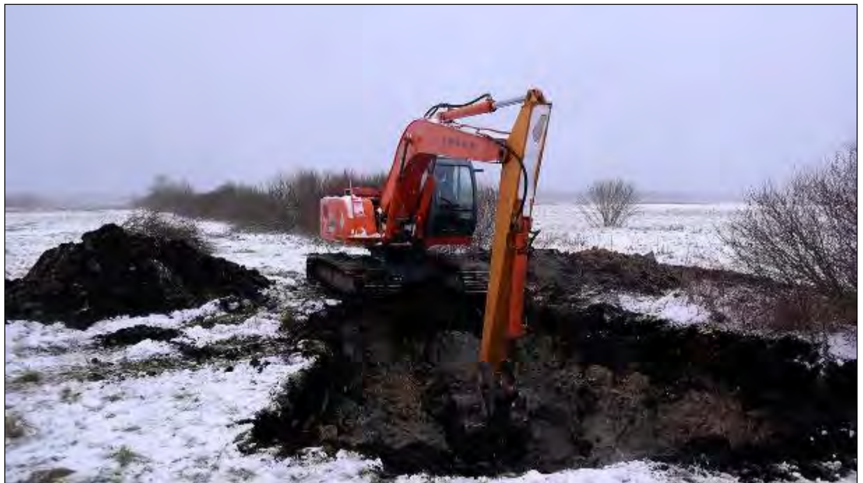
Рисунок 4.1.6 – Строительство плотин на крупных дренажных канавах экскаватором с 1,5 м шириной гусениц, приспособленных для работы на болоте (Дикий Никор, Беларусь, декабрь 2016)
