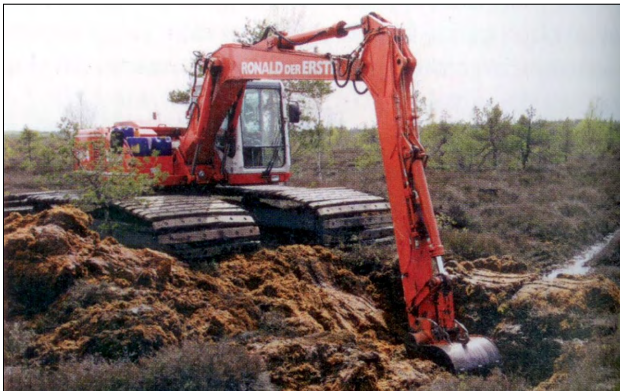
Рисунок 4.1.2 – Строительство плотин на крупных дренажных канавах экскаватором с 1,5 м шириной гусениц, приспособленных для работы на болоте (Vasenieki Mire, Латвия)
