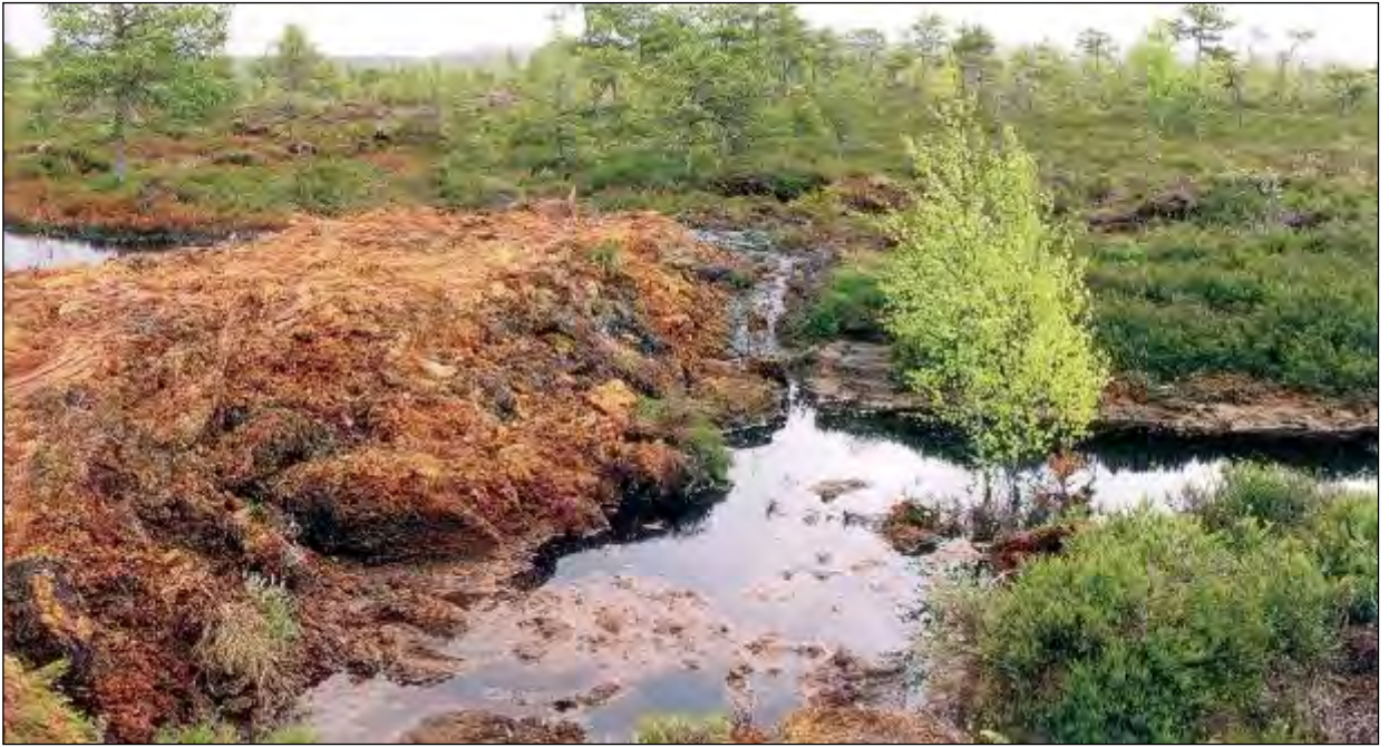
Рисунок 4.1.5 – Если плотина построена правильно, вода направляется вдоль канавы, таким образом, наводняя болото
