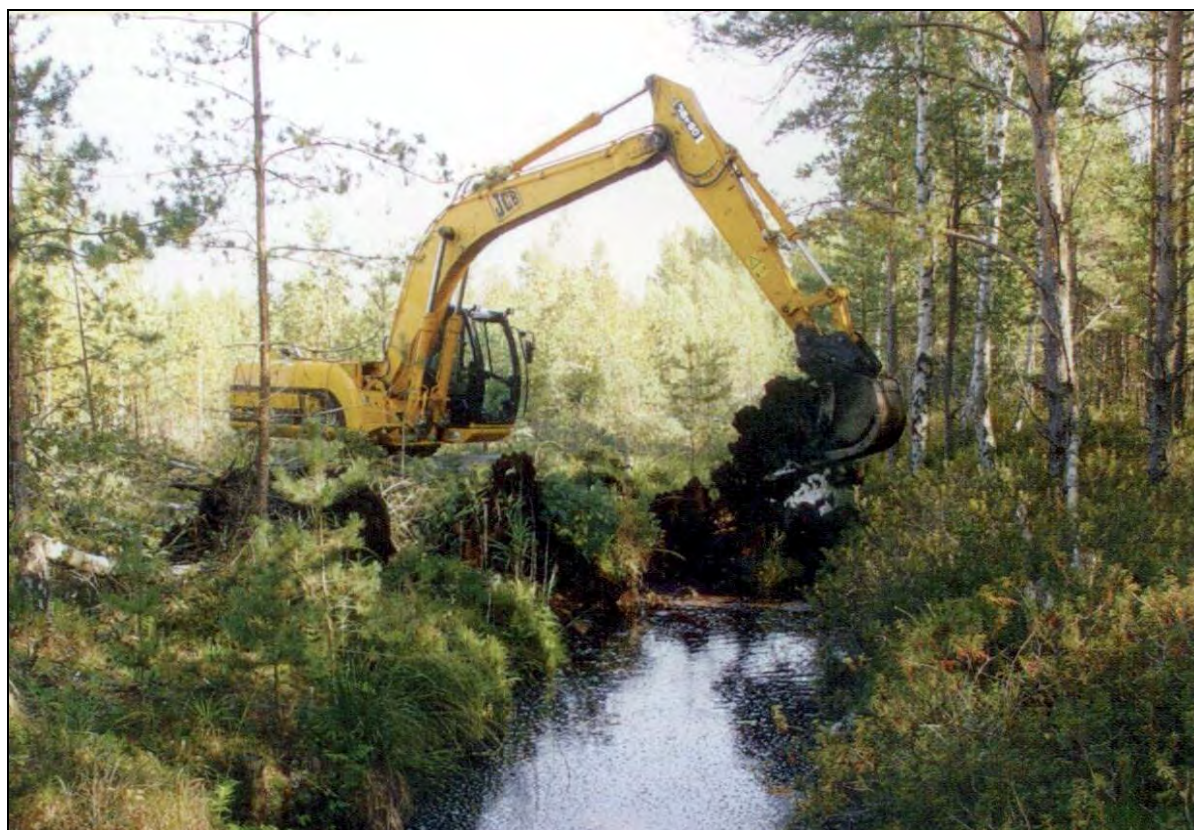
Рисунок 4.1.3 – Строительство торфяных плотин экскаватором с шириной гусениц 0,8 м (сентябрь 2006)
